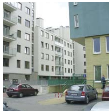
Budynki przy ul. Pięknej 7 i Pięknej 9
